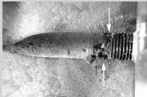
Seisovan jäähdytysveden aiheuttamat korroosioauriot kanavassa.
